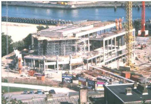
Conservation de la charpente du casino
