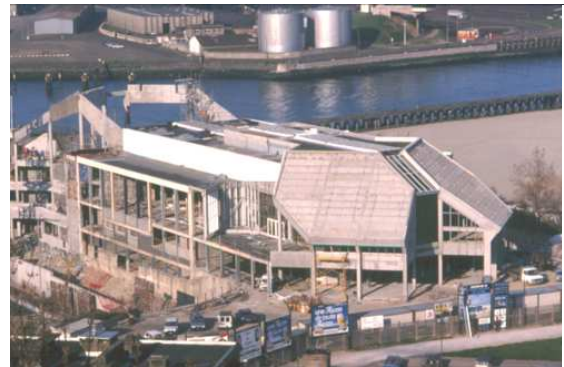
Nouvelle structure de carapace en béton
